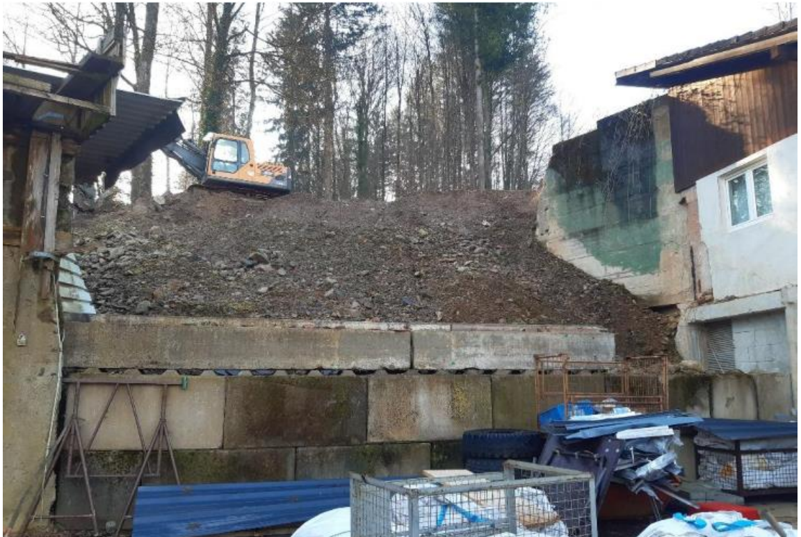
Abb. 2: Lücke zwischen der bestehenden Bebauung im Plangebiet, erkennbar dadurch der Geländeversprung nach Westen und der weiter oben liegenden Weg (Quelle: faktorgrün, Stand März 2026)
