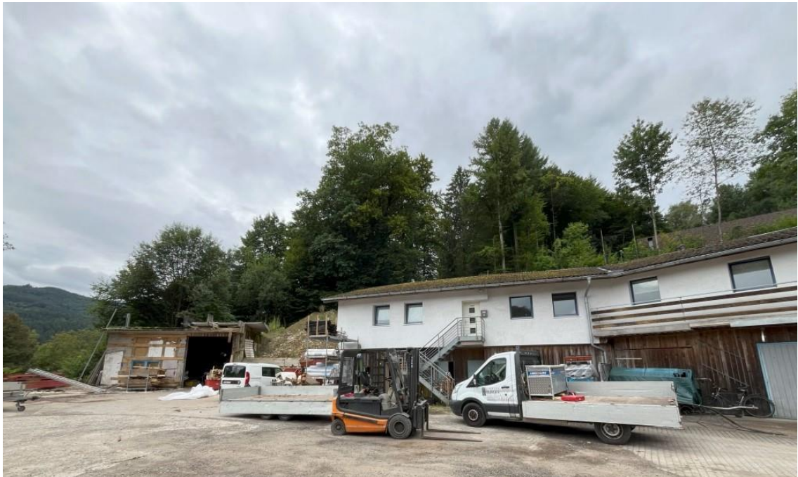
Abb. 3: Bestehende Bebauung im Westen des Plangebiets mit dem massiven Geländever-sprung hinter der Bebauung und dem deutlich weiter oben liegenden Weg (eigenes Foto)
